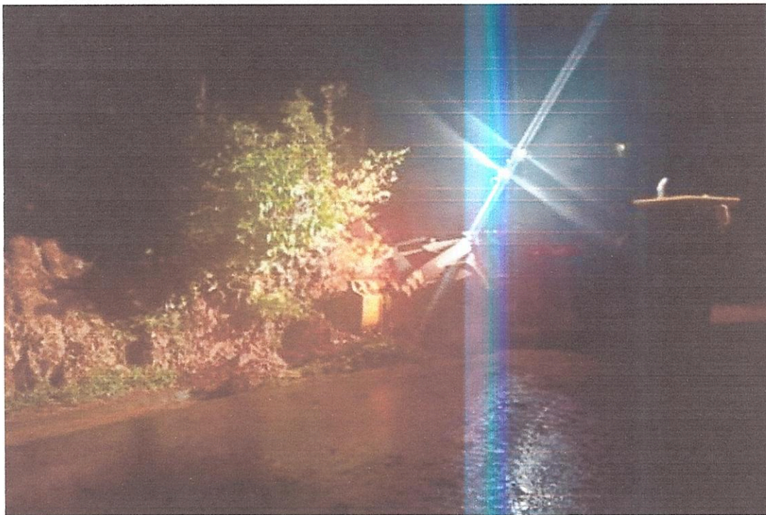
Limpeza de via
